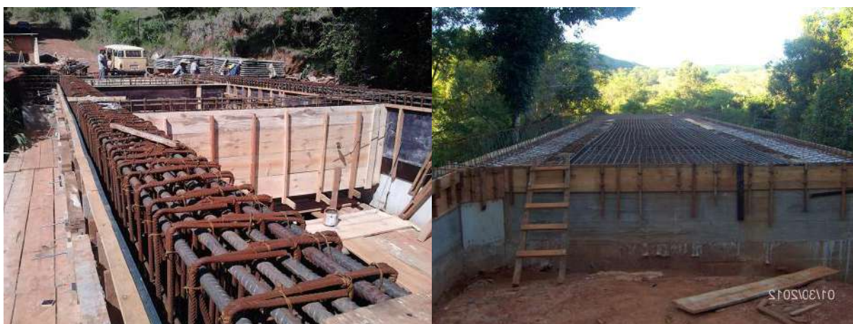
Figura 14.8 – Complemento das vigas e tabuleiro.
