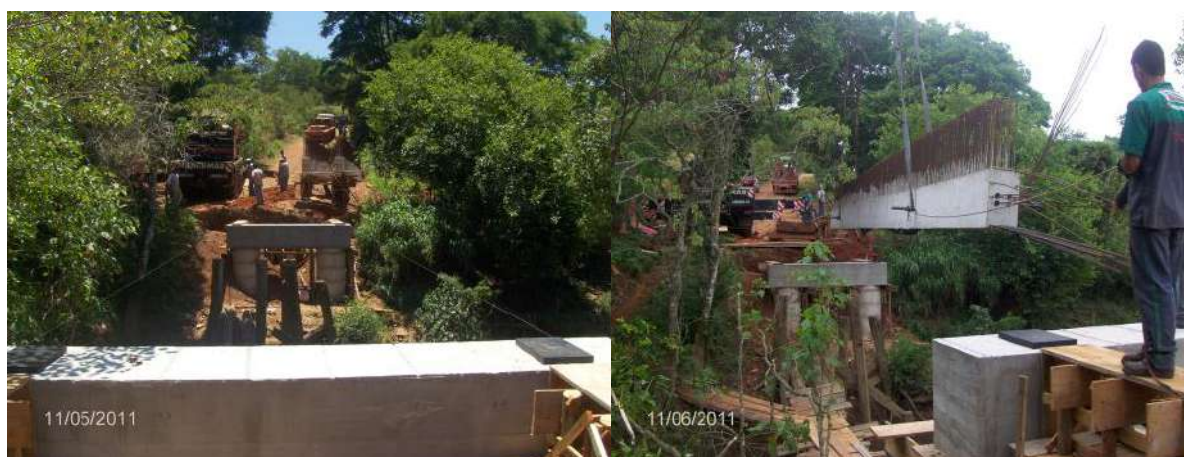
Figura 14.6 – Lançamento das vigas.
