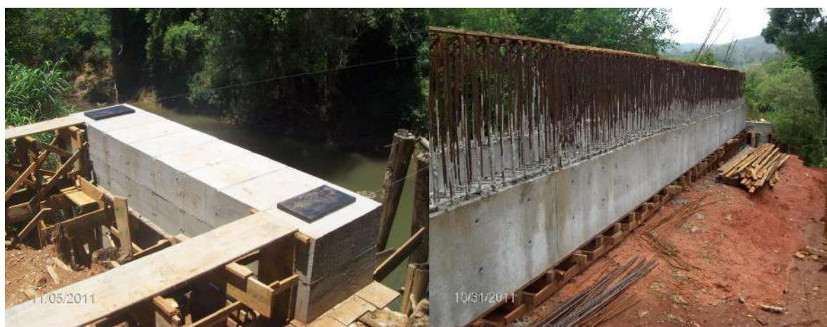
Figura 14.4 – Travessa e vigas prontas para lançamento.
