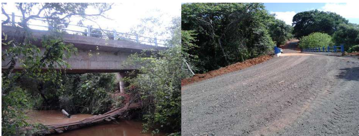
Figura 14.9 – A obra concluída.
