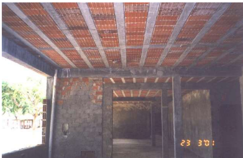
Foto 7.1 – Vista parcial da laje de piso ainda na fase de construção.
