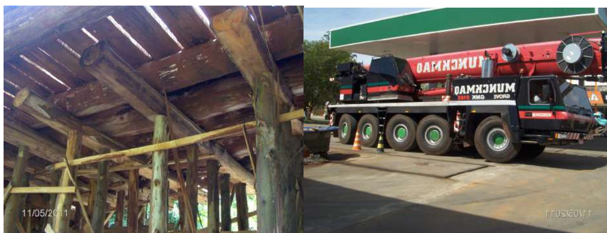
Figura 14.5 – Ponte de madeira existente escorada para passagem do guindaste de 220 t.
