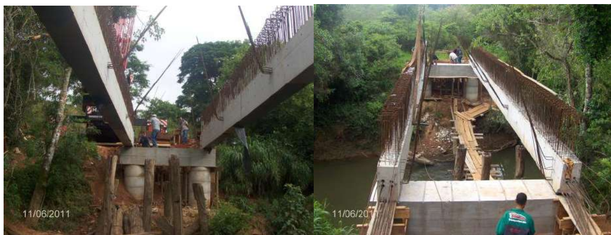
Figura 14.7 – Vigas lançadas já em posição.
