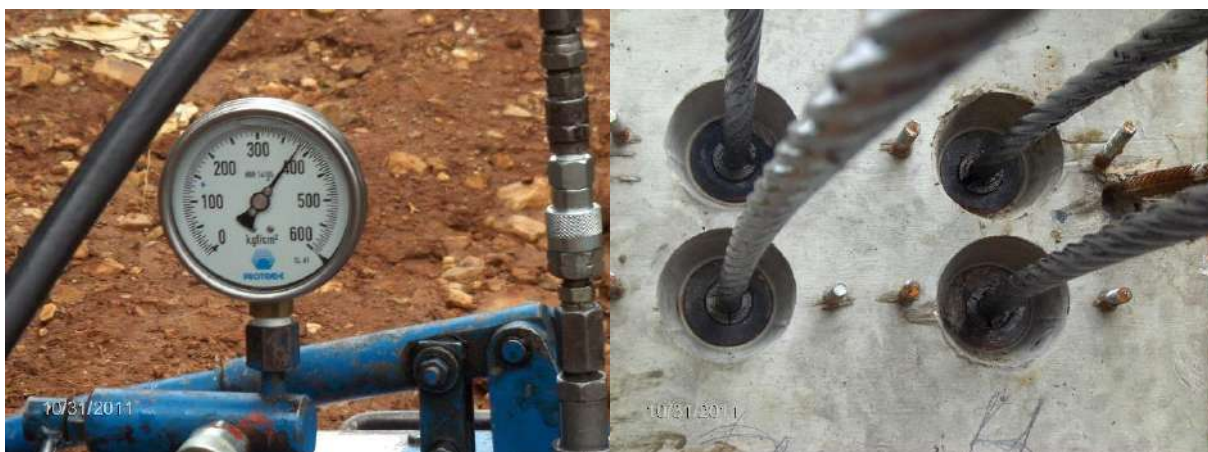
Figura 14.3 – Cordoalhas e protensão das vigas.
