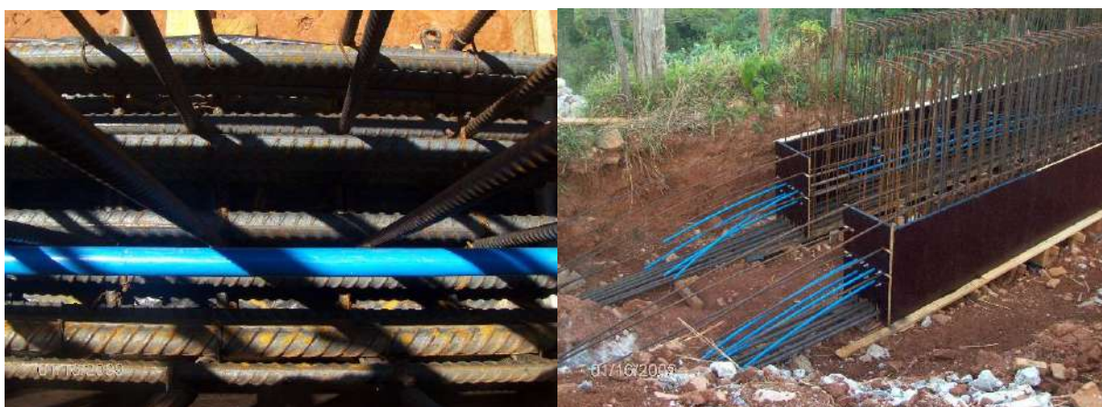
Figura 14.2 – Assentamento das cordoalhas engraxadas.
