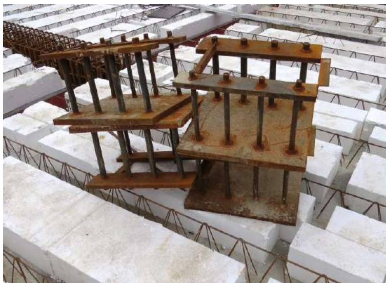
Foto 8.1 – Insertos de uma estrutura metálica
